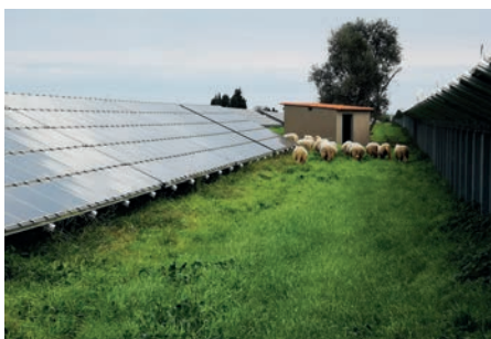
Photo 14 : Brebis pâturant dans un parc photovoltaïque à tables fixes à Torreilles (66) (© Neoen)
