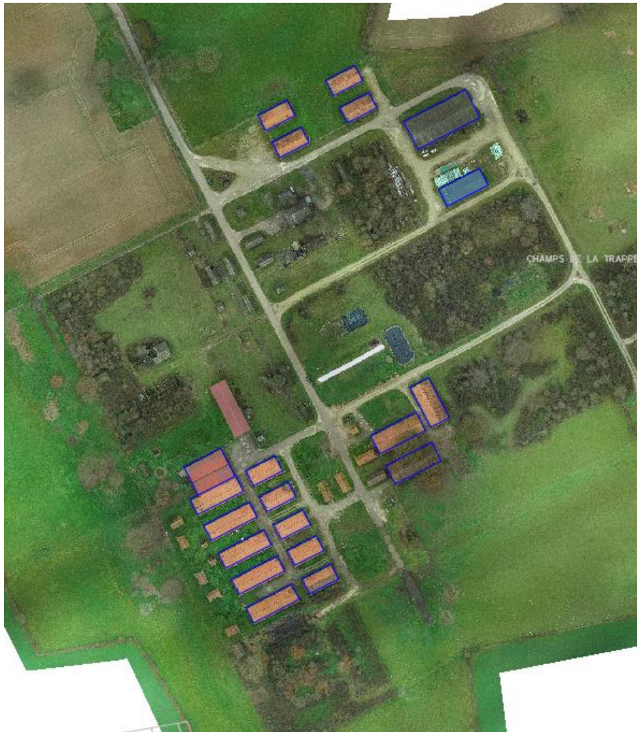
Illustration n° 35 : Les toitures réhabilitées
