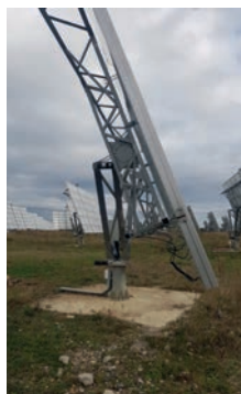
Photo 31 : Double-tracker mono-pieu sur dalle de béton (© Idele)
