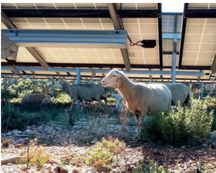
Photo 8 : Centrale photovoltaïque du Castellet (© Voltalia)
